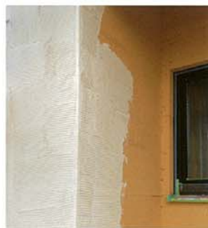
モルタル直塗りだからこそ、 塗りなおして気密性能を復元
