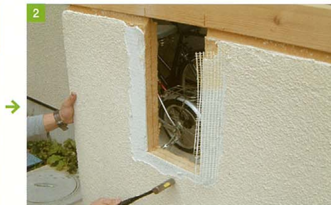
透湿モルタルシステム(モルタル直塗り)だからこそ、塗りなおして 断熱・気密性能を復元
