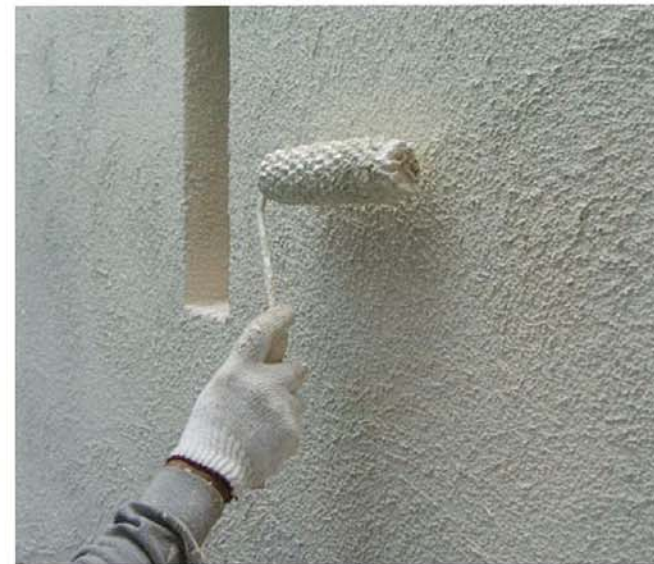
仕上げ塗料の塗り込み
