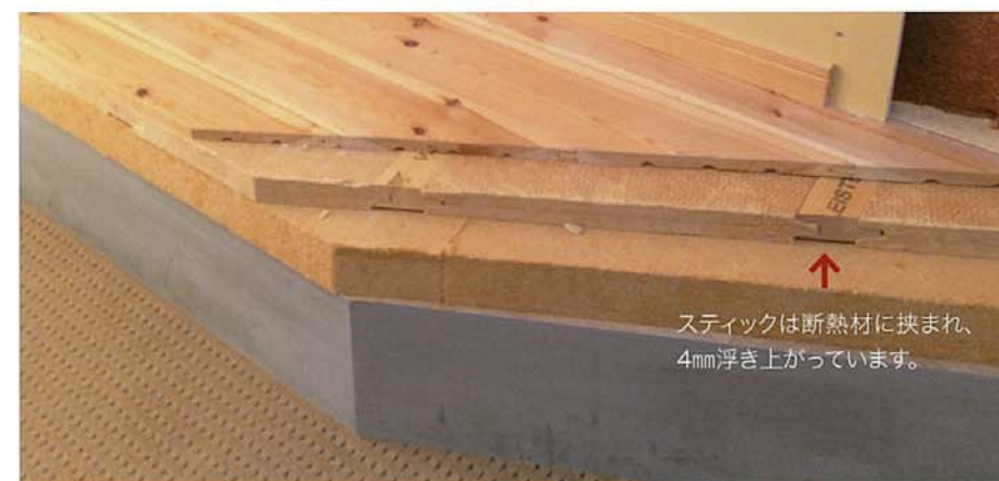
床用ECOボード断面模型
