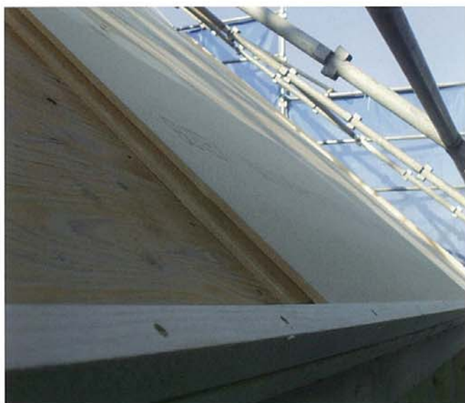
ECO断ルーフの張り始め
