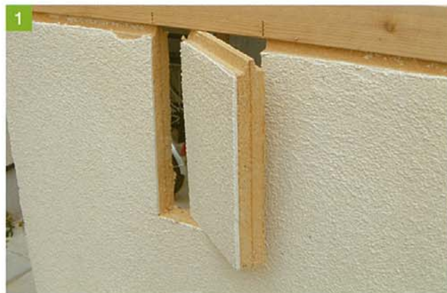
断熱材の一部が劣化しても、部分的に張り替えることが可能
