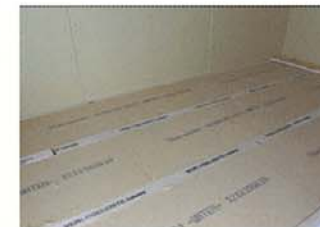
ECO断フロア40の敷込み
