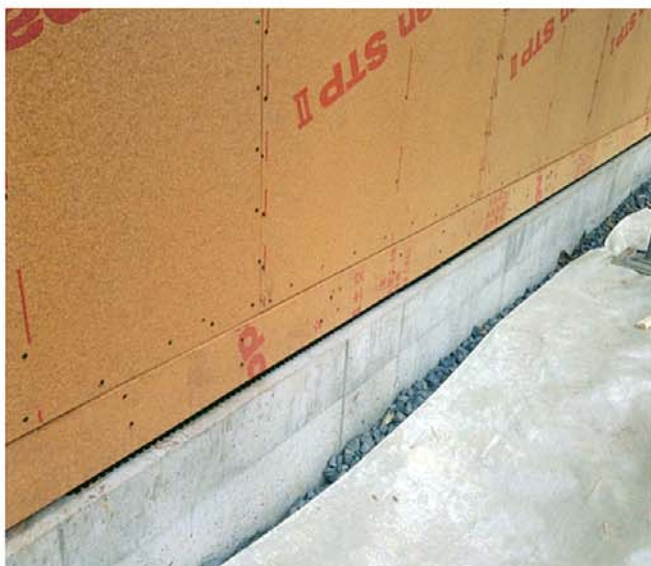
スターターの取付け準備
