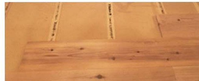
フローリング貼り
